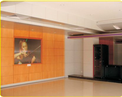
深圳高阳万国数据中心
