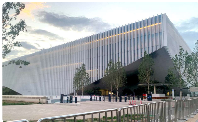
腾讯计算机系统有限公司北京总部
