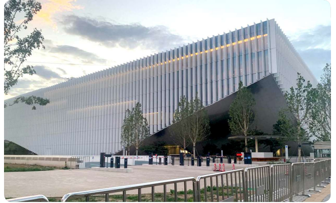
腾讯计算机系统有限公司北京总部
